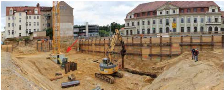
Abb. 13: Baugrube von Haus A mit aufgeschlossenen gelbbraunen Kiessanden. Der Pfeil markiert die Lage von Abbildung 14 und dem Lackprofil. Blick nach Süden. Foto: O. Tietz, 18.8.2021
