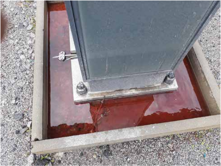
Abb. 21: Betonbecken in Bautzen mit rotem Bodensatz von Sporen der Blutregenälge. Foto: U. Hornig
